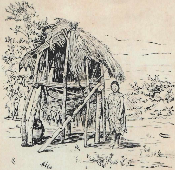
Granero chané, construido sobre pilotes.
